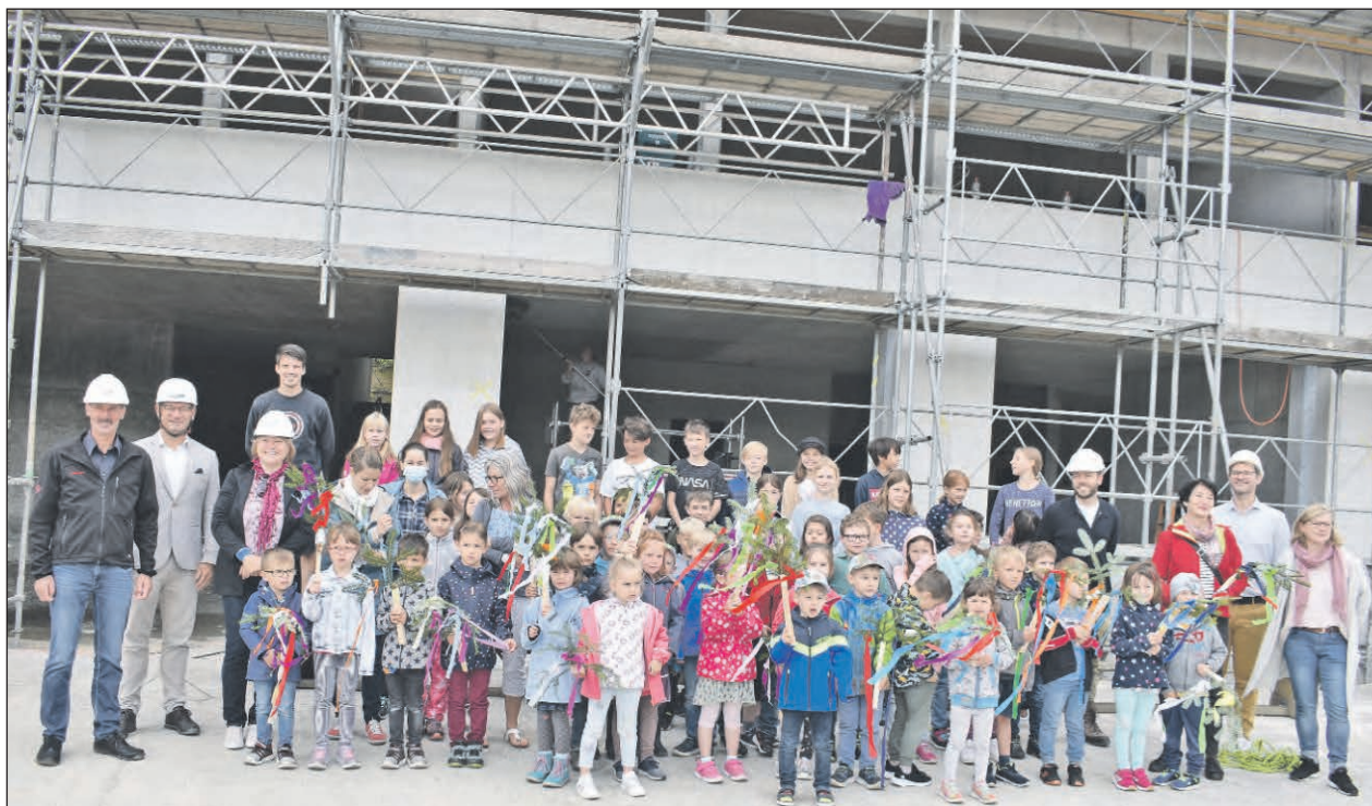
Ein weiterer Meilenstein: Auf der Birrwiler Schulhausbaustelle konnte das Aufrichtefest gefeiert werden, im Frühling soll das neue Schulhaus bezugsbereit sein. (Bilder: hg.)
